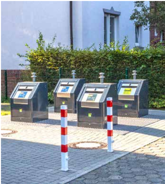
An der Friedrich-Harkort-Straße ist ein neues Abfall- und Recycling-Unterflursystem errichtet worden.
