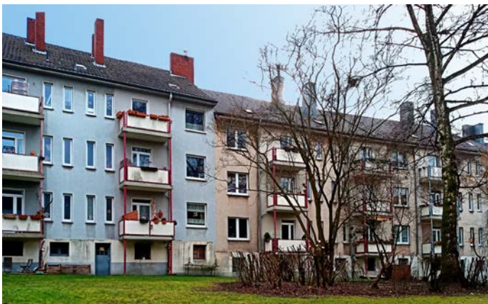
Quartier Erbhof 5-9 vorher / nachher
