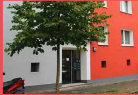
Die energetische Sanierung an der Heckertstraße ist beendet. Auch optisch ein großer Wurf. Fotos: Nina van Bevern
