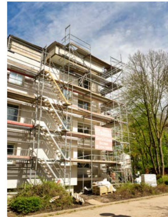
Vierhausstraße Modernisierung im Gang
