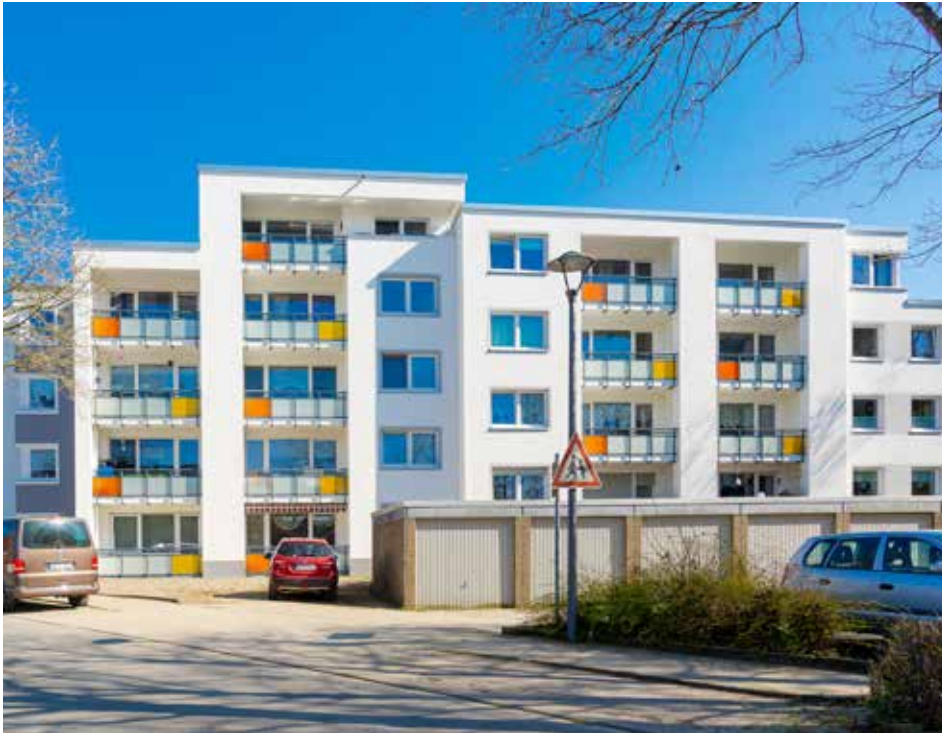
Bei den Häusern am Chursbusch sieht man ganz deutlich den Effekt energetischer Modernisierungen.
