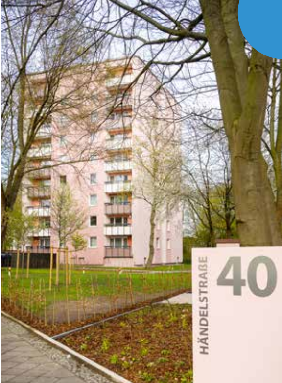
Ein Quantensprung: die Händelstraße 40 vor und nach der umfangreichen Modernisierung.
