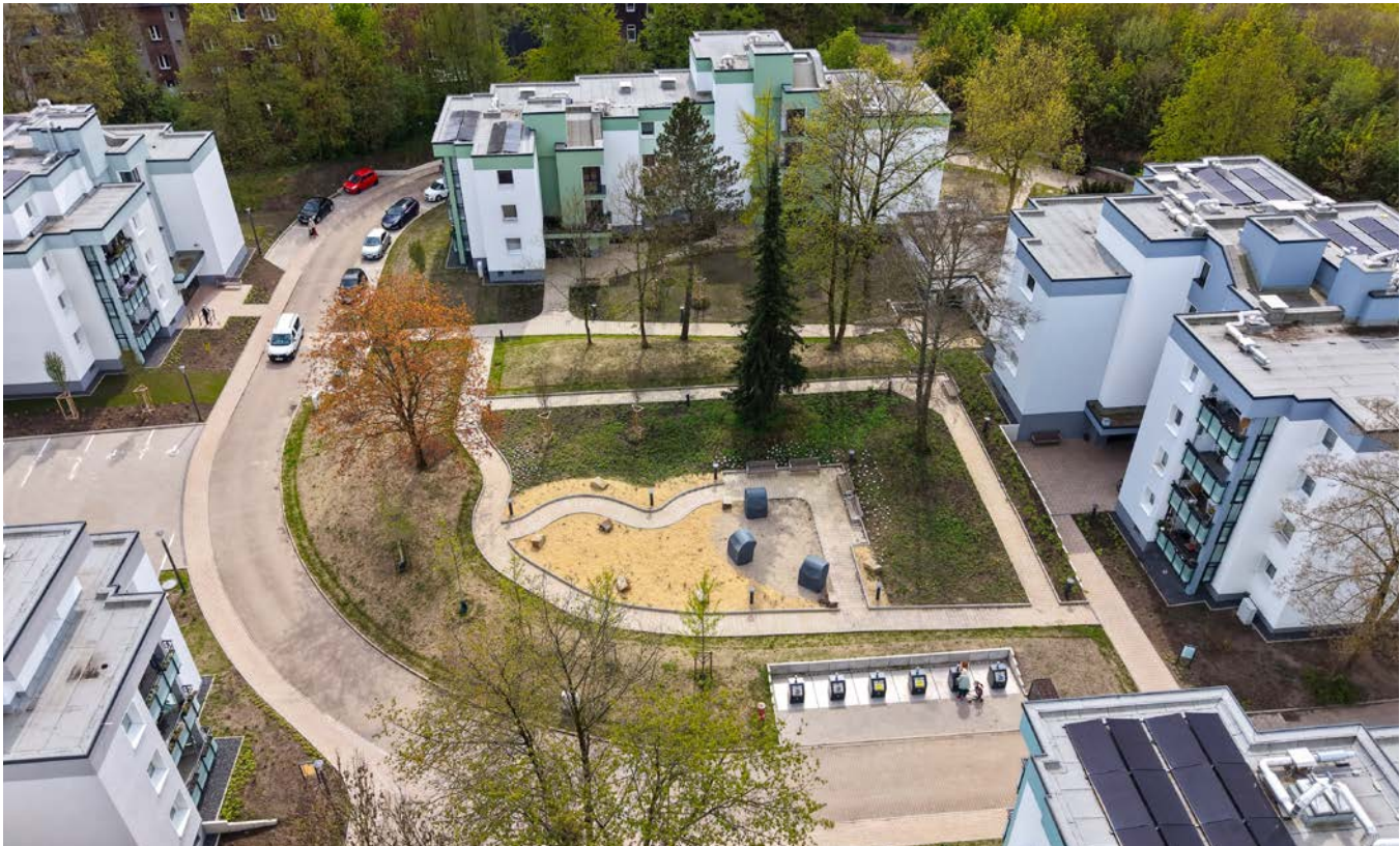
Fertigstellung der Modernisierung Vierhausstraße
